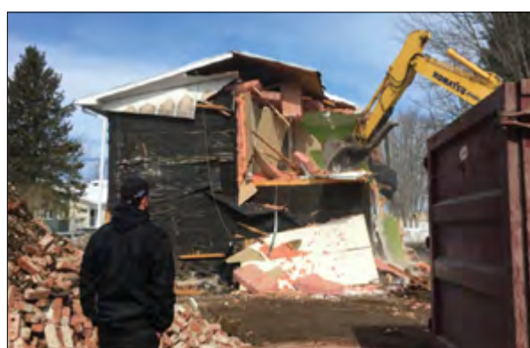
Fait sans précédent au Québec, 32 logements HLM sont tombés sous le pic des démolisseurs le 22 mars dernier à Daveluyville.
