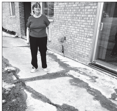
À Mont-Carmel, dans le bas Saint-Laurent, les trottoirs sur le terrain de l'office ont besoin d'être refaits. Récemment, une locataire s'est blessée à cause du mauvais état des lieux.
