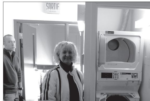
À Laurier-Station, à l'Ouest de Québec, les locataires ont maintenant une buanderie au 2 e étage. Le type d'installation mérite d'être soulignée. Pour compenser l'exiguïté des lieux, on a installé des appareils à chargement frontal superposés.
