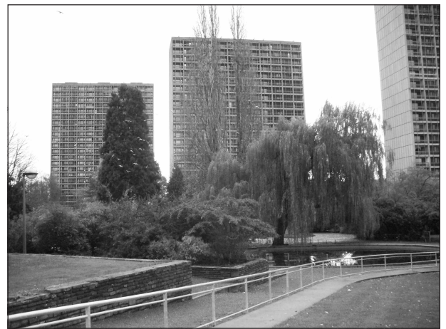
HLM en déconstruction à Droihxe.
