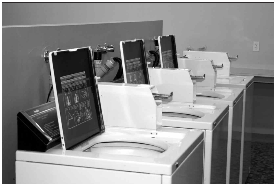
La ministre a promis de voir à l'aménagement de salles de lavage pour mieux tenir compte des besoins des locataires.
